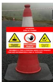
El operador del polipasto no comenzará las operaciones de comprobación hasta que el personal de la “playa del aerogenerador” se encuentre fuera de la zona balizada. Solo podrá invadirse la zona balizada para conectar o desconectar la carga del gancho del polipasto cuando la carga esté en el suelo.
